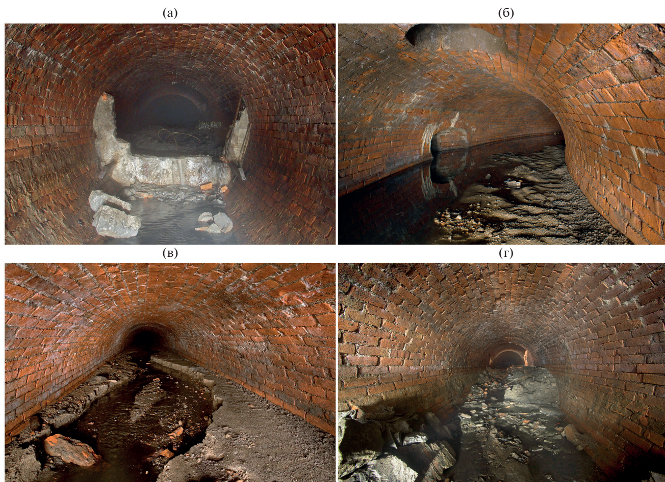
Рис. 2. Техноаллювиальная толща в коллекторе Калитниковского ручья в 2011 г.: бетонная перегородка во время демонтажа (а); техноаллювиальная толща в 265 м выше плотины (мощность на всем протяжении практически идентичная) в месте сужения коллектора (б); после демонтажа перегородки ручей начал стремительно врезаться в наносы (в, г). Фото С.А. Корнева и В.А. Неходцева.
