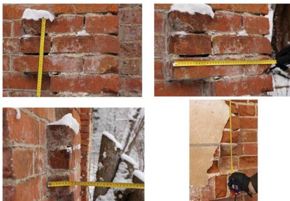
Рис. 11. Замер рустовки, предназначенной для украшения углов дома. Ноябрь 2022 г. Снимки автора статьи.
