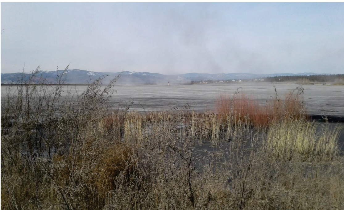
Рис. 1. Золоотвал ТЭЦ-1 г. Улан-Удэ Fig. 1. Ash dump of CHPP-1, Ulan-Ude
