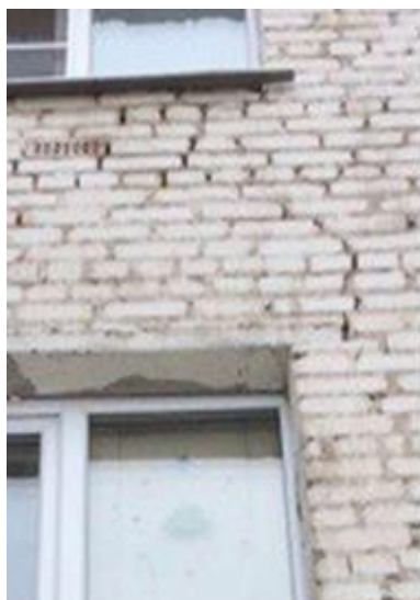
Вертикальная сквозная трещина между этажами
