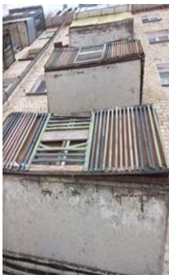
Разрушение ж/б балконной плиты, коррозия арматуры
