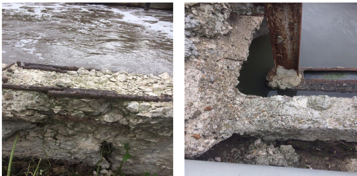
Рис. 2. Воздействие агрессивной среды на железобетонные конструкции (разрушение бетона и коррозия арматуры).
