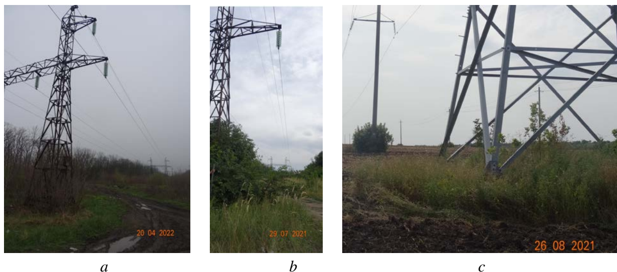
Фото 2. Нежелательная растительность на территориях трасс линий электропередачи: a — ПС КБХА — ПС Южная, апрель 2022 г.; b — ПС КБХА — ПС Южная, июль 2021 г.; c — ПС Красная Яруга — ПС Томаровка, август 2021 г.
