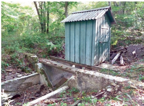
Рис. 6. Слева – водослив на гидрометрическом посту 3-го ручья ЛГС “Горский”. Справа – повреждения поста после катастрофического паводка в 2001 г.
